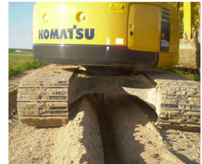
Figure IV.1 : Tranchée d'enfouissement des câbles électriques
