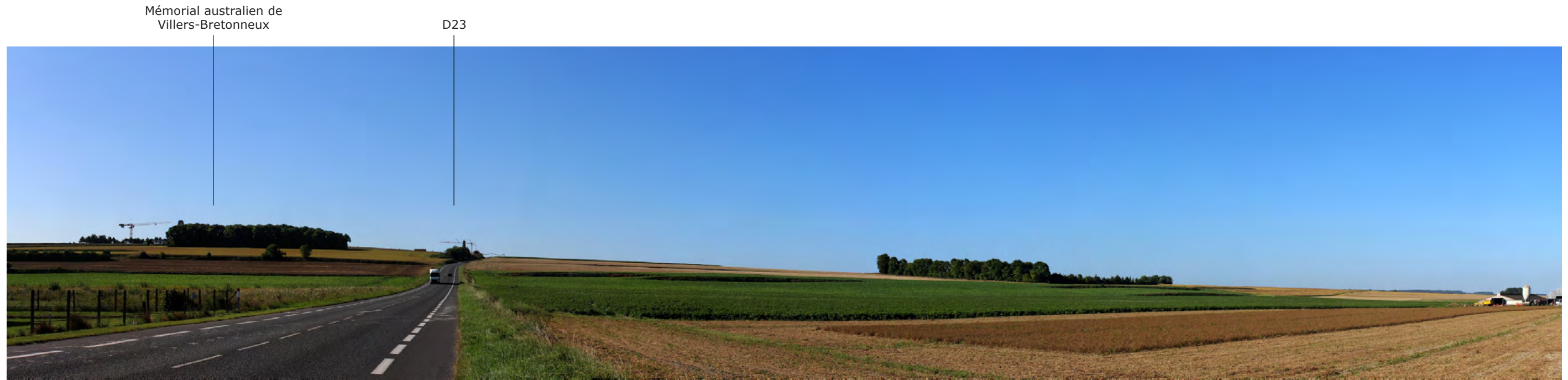
Le paysage sans éoliennes (état initial) - vue depuis la sortie sud de Fouilloy
