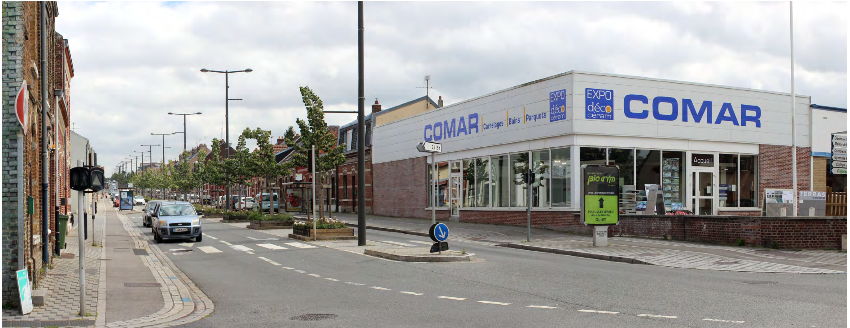
Le paysage sans éoliennes (état initial) - vue depuis la D934 à Longueau
