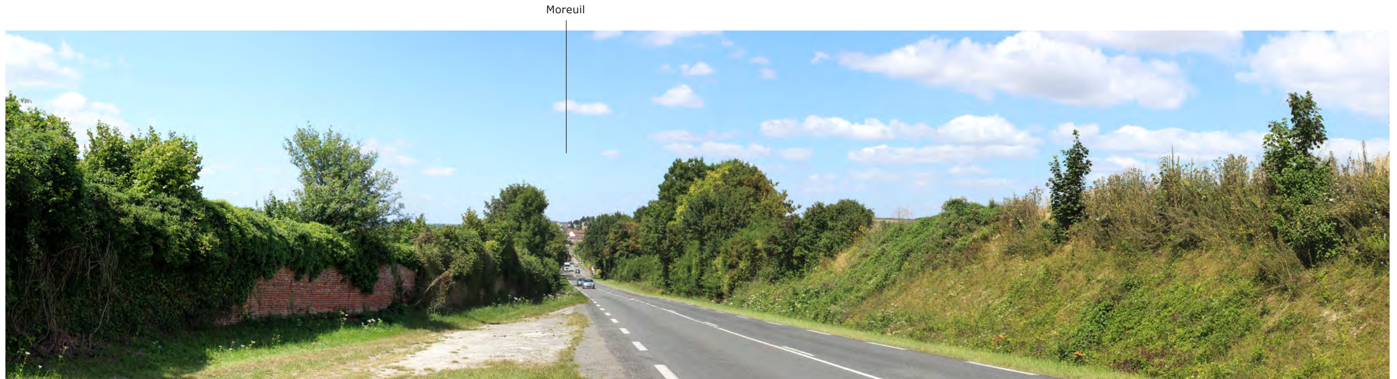
Le paysage sans éoliennes (état initial) - vue depuis la route départementale D935 au sud-est de Moreuil
